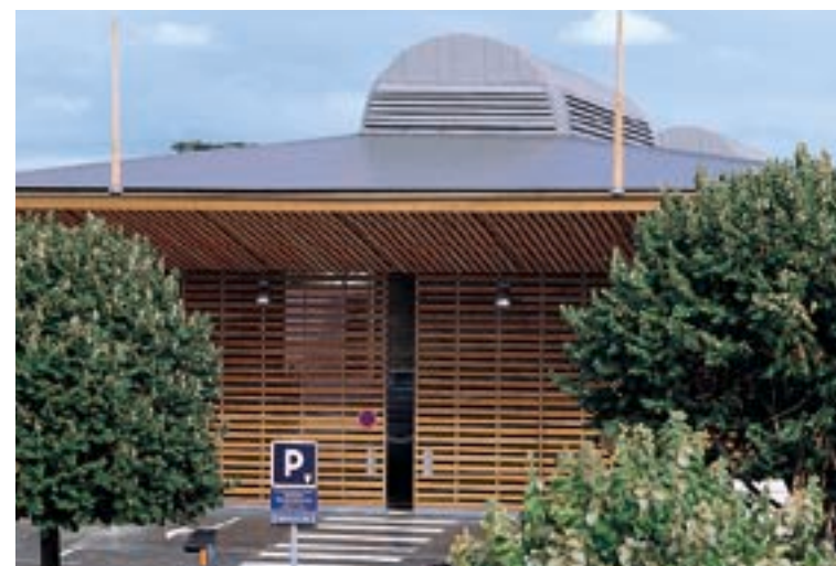
▲ En toiture, un lanterneau apporte air et lumière naturelle.
