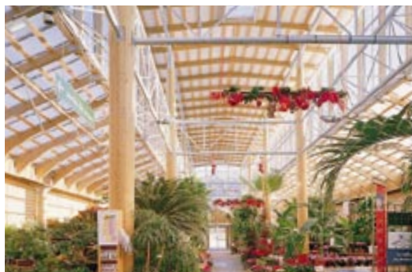
▲ Dans la serre, une structure mixte en bois lamellé-collé d'épicéa et métal forme une résille légère.
