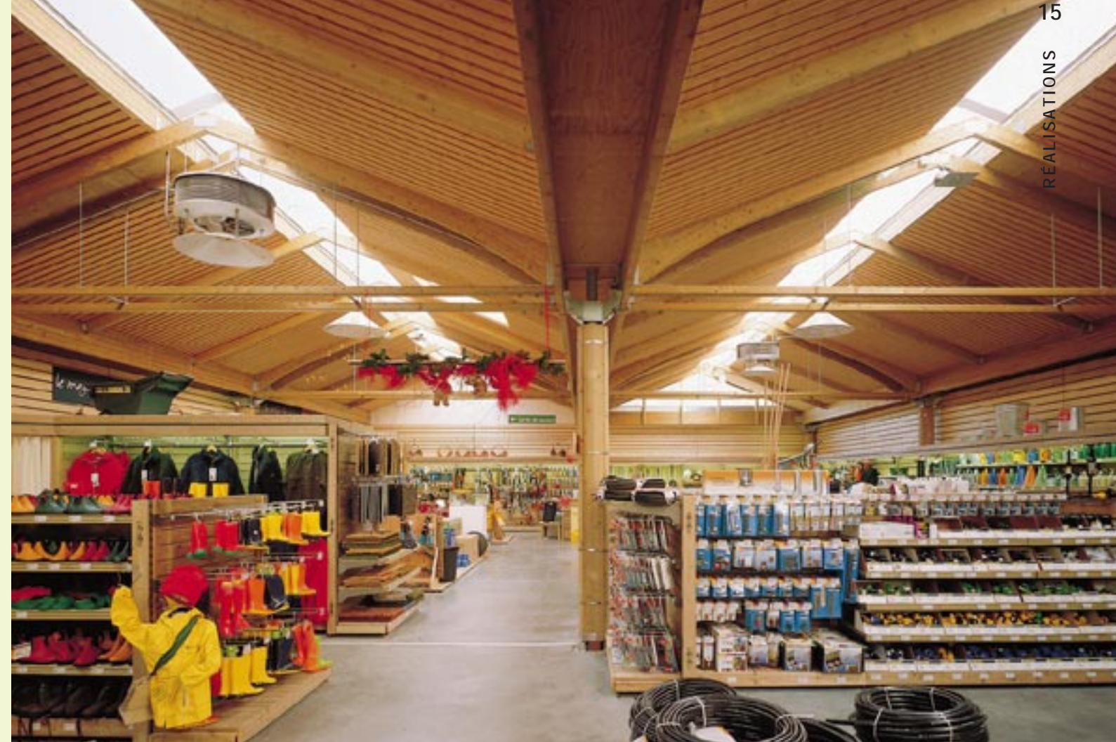
▲ A l'intérieur du magasin, le bois est décliné sous différentes formes : structures en bois lamellé-collé, parois et plafond d'épicéa, mobilier menuisé.
