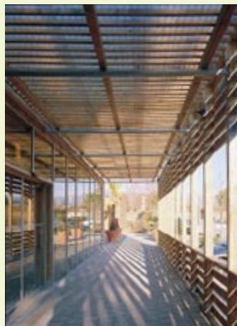
▼ Une galerie extérieure en bois forme un sas entre le parking et le magasin.
